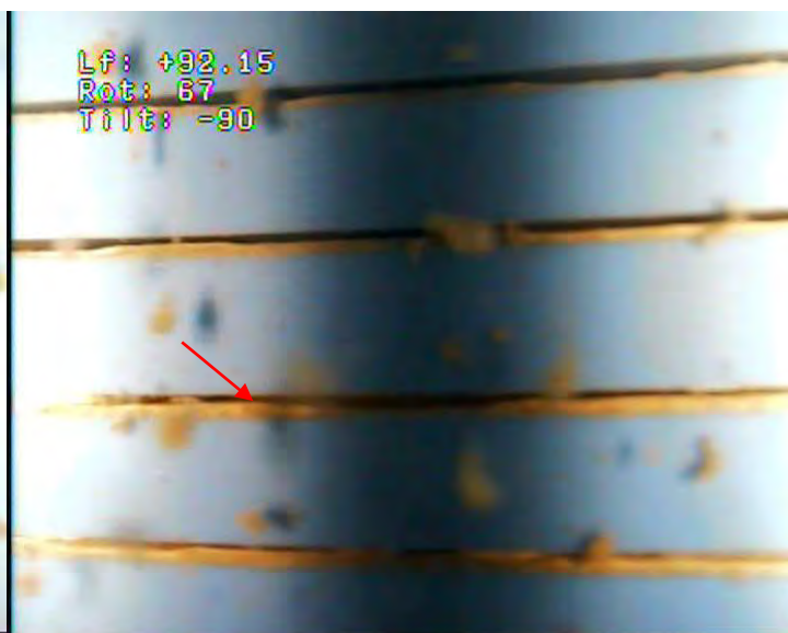
84 – Crépine PVC en Ø 263/273 mm – Crépines partiellement colmatées
