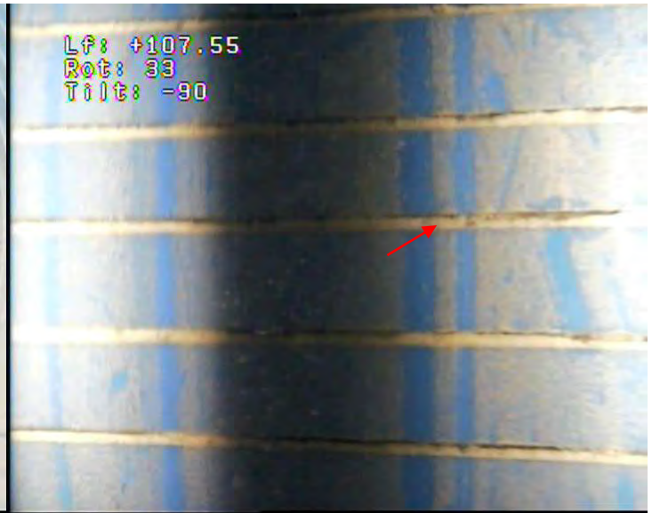
108 – Crépine PVC en Ø 263/273 mm – Crépines colmatées
