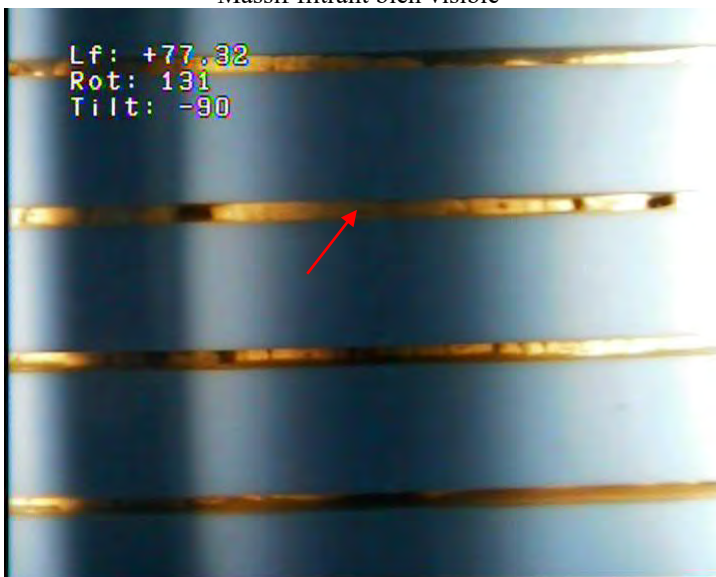
63 – Crépine PVC en Ø 263/273 mm – Crépines bien ouvertes Massif filtrant bien visible
