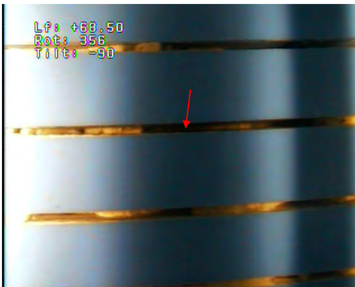
51 – Crépine PVC en Ø 263/273 mm – Crépines bien ouvertes
