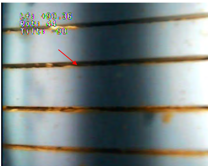
81 – Crépine PVC en Ø 263/273 mm – Massif filtrant absent ?
