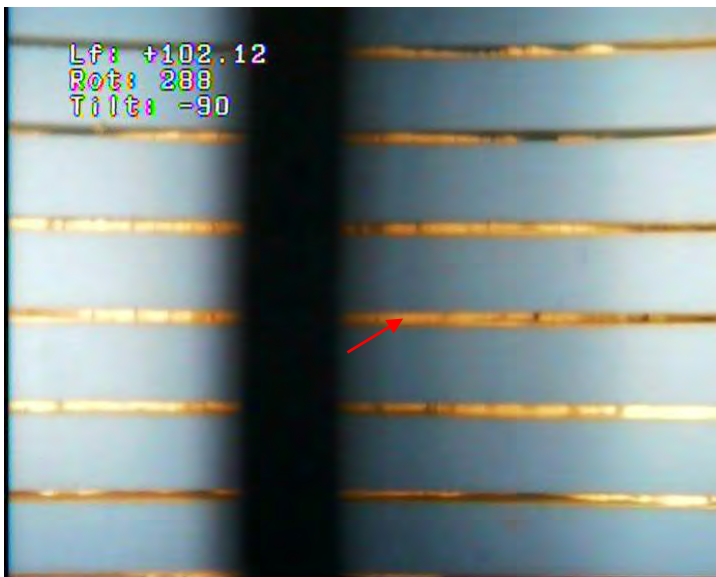
99 – Crépine PVC en Ø 263/273 mm – Crépines bien ouvertes
