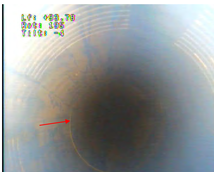
87 – Crépine PVC en Ø 263/273 mm, raccord n° 32
