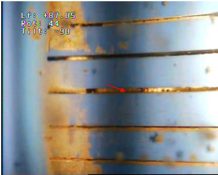
77 – Crépine PVC en Ø 263/273 mm – Crépines bien ouvertes
