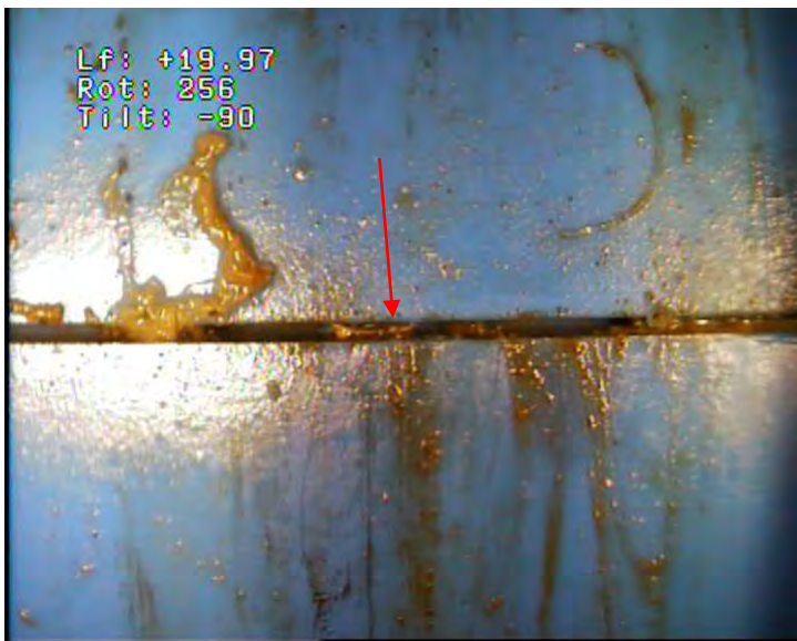
15 – Tubage PVC plein en Ø 263/273 mm, raccord n° 7
