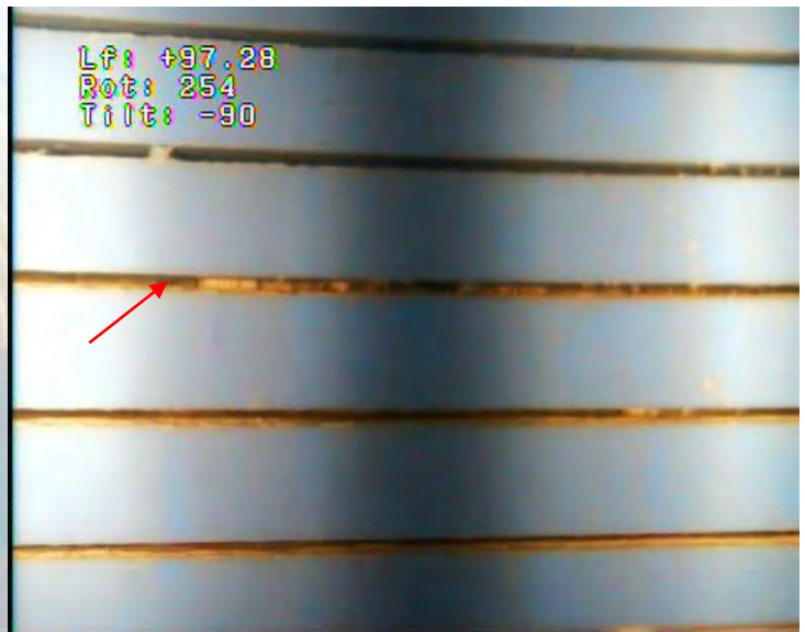
92 – Crépine PVC en Ø 263/273 mm – Crépines bien ouvertes
