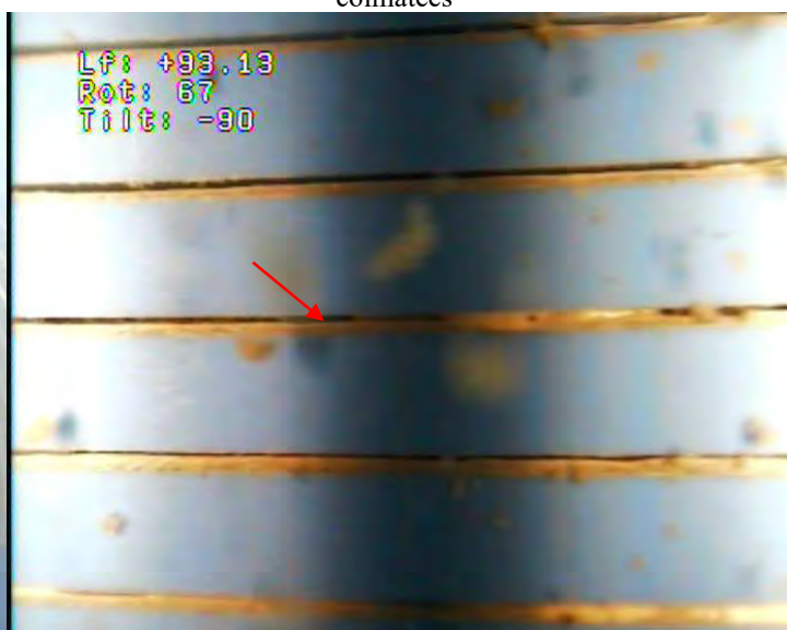
86 – Crépine PVC en Ø 263/273 mm – Crépines partiellement colmatées
